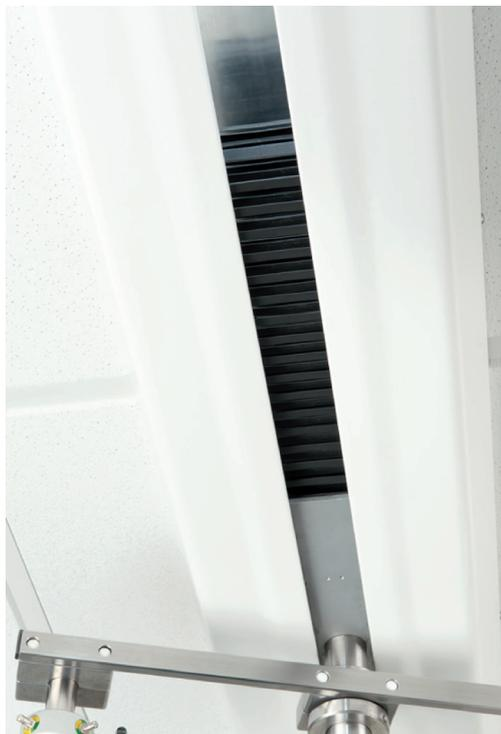
*Distanzstücke - zur Überbrückung von Zwischendecken*
